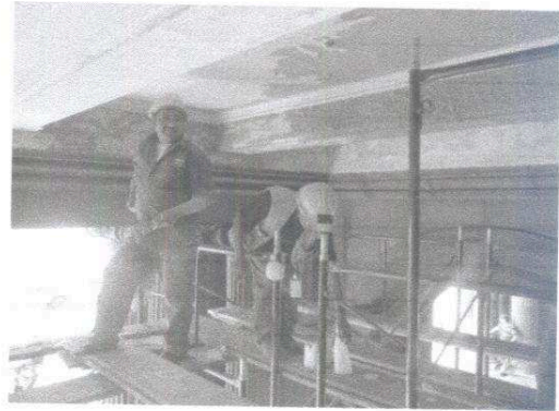
Preparación del área para iniciar a fondear
