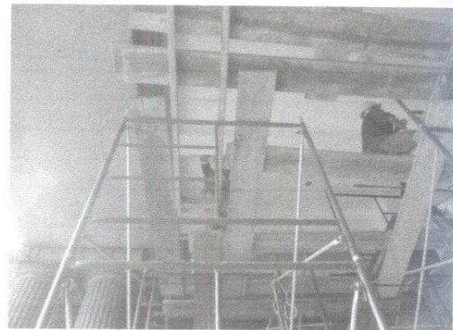
Colocación de Andamio
